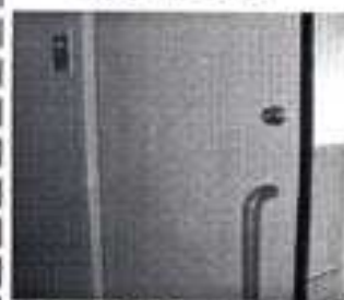
* 1 引き戸に改修
